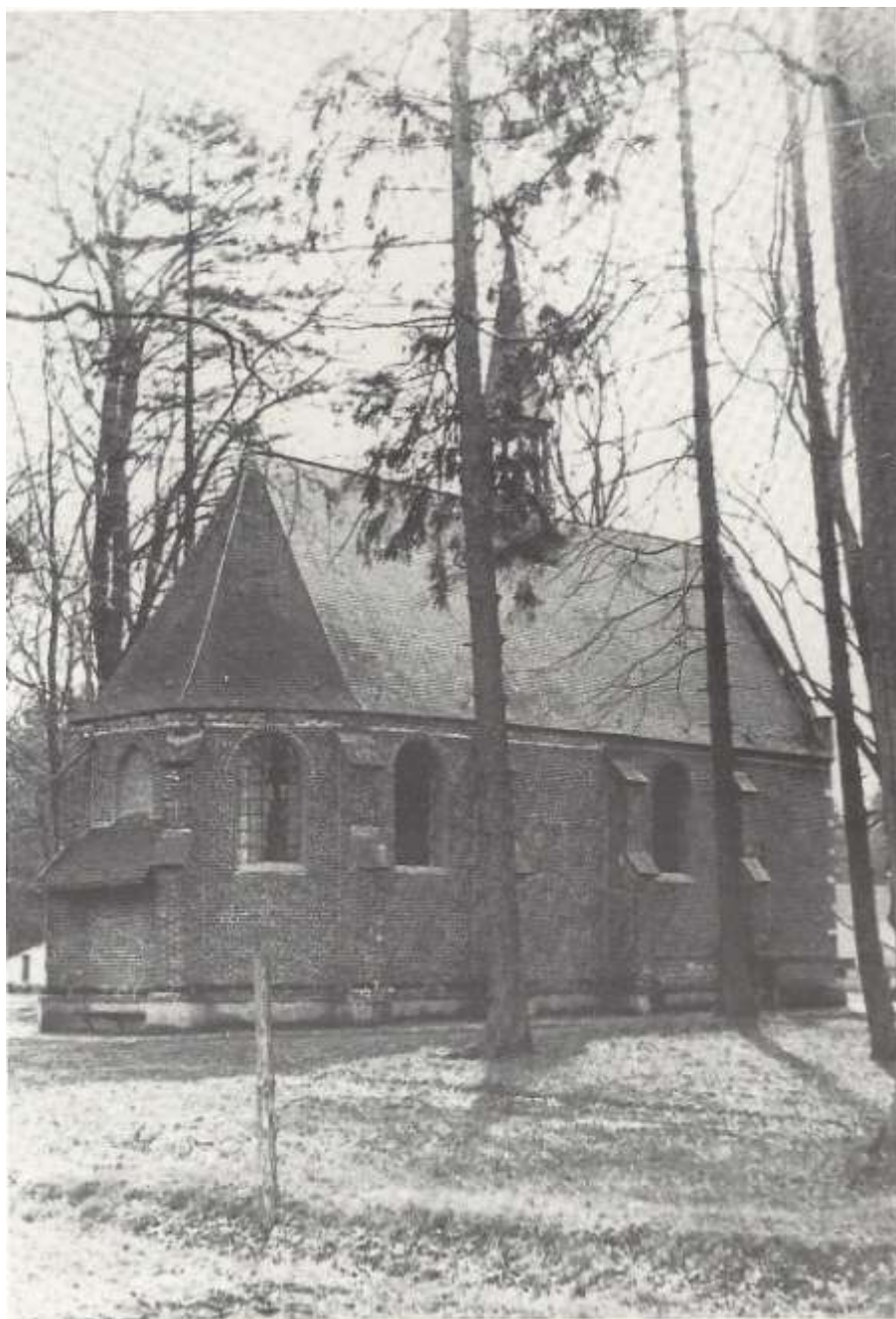
Afb. 3: De Heggekapel, zicht vanuit het noorden op de noordwestgevel en het koor (1987). Merk duidelijk de 'sperlaag' Poederleeiaan. (Foto: W. Van den Branden)
